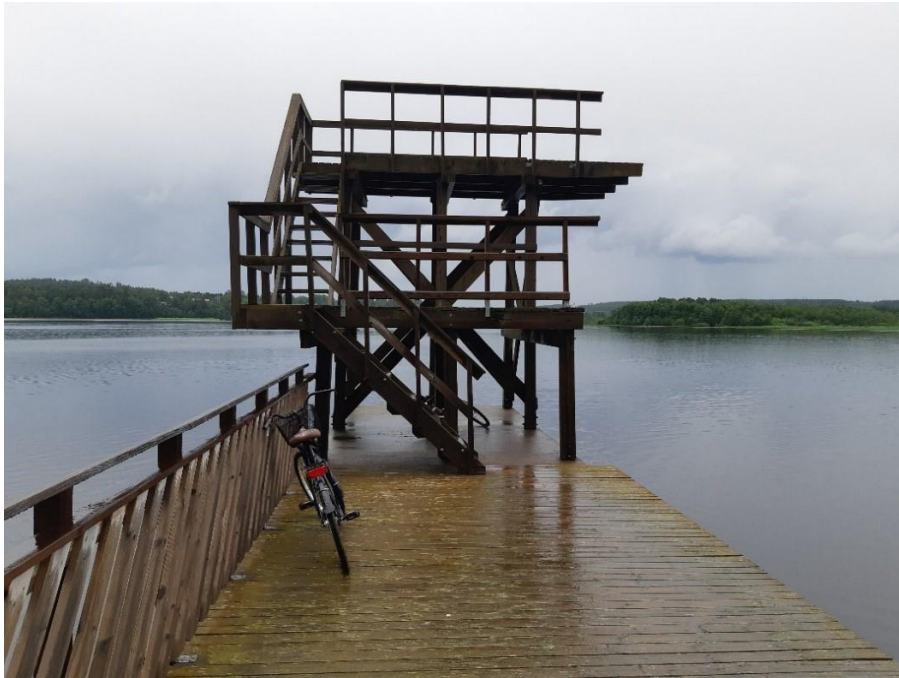
Bild 11. Hopptornet på bilden är cirka fem meter högt. Det kräver ett vattendjup på minst fyra meter i alla förhållanden. Ibland hittas cyklar eller andra okända föremål i vattnet som har hamnat i närheten av hopptorn. Strandens upprätthållare ska regelbundet inspektera vattenområdet. Pyhäjärvi badstrand, Högfors.
