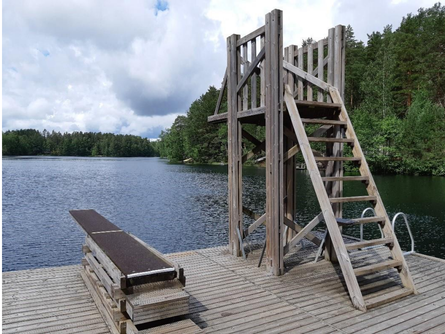
Bild 4. På bryggan har det installerats en trampolin på en meters höjd och ett över två meter högt hopptorn. Ett vattendjup på minst 3,5 meter krävs i alla förhållanden. Nummijärvi badstrand, Somero.
