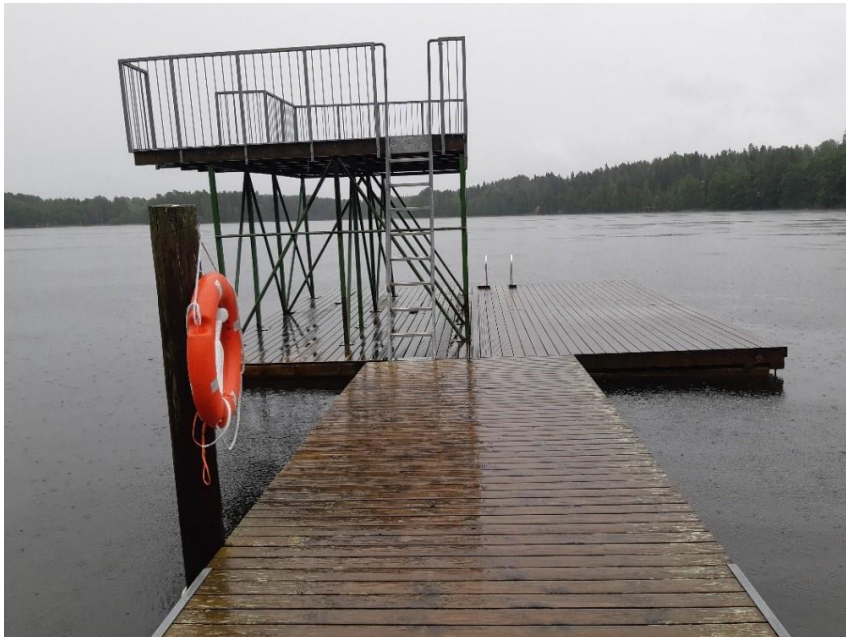
Bild 3. Hoppturnet på bilden överskrider två meter. Det kräver ett vattendjup på minst 3,5 meter i alla förhållanden. Avsatsen har spröjsräckan som ska göra det svårare att klättra upp på räcket. Livbojen är lättillgänglig och på bryggan har man installerat en stege för att det ska vara lättare att ta sig upp ur vattnet på bryggan. Otalampi badstrand, Vichtis.
