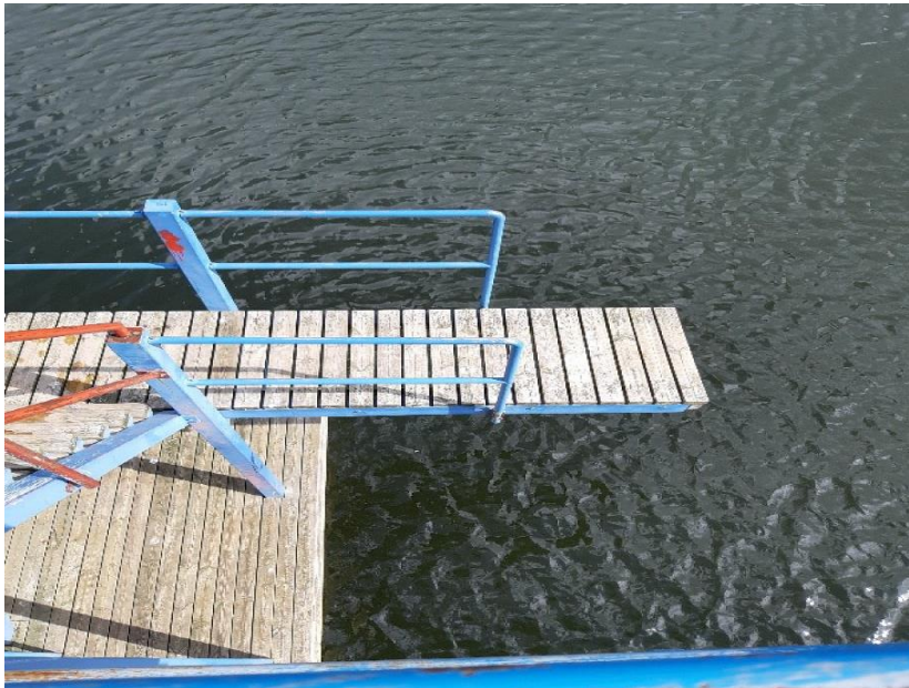
Bild 5. Avsatsen måste räcka över vattnet. Avståndet från framkanten på avsatsen till kanten på bryggan ska vara över en meter. Överdrivet långa avsatser lockar till att springa och ta sats. Linikkalanlammi badstrand, Forssa.
