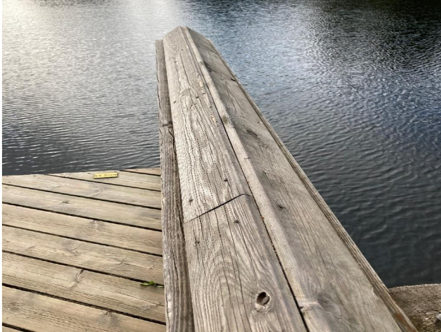
Bild 6. Kunderna klättrar upp och hoppar från räckena på hopptornen. Detta kan minskas med till exempel den trekantiga strukturen som visas på bilden. Mytjäjäinen badstrand, Lahtis.
